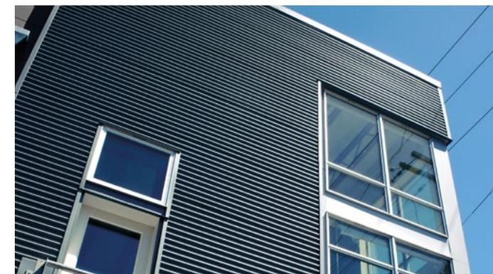
La protezione avanzata contro la corrosione inizia con la categoria **C3 (Media)**. In questo caso, si utilizzano principalmente prodotti bicomponenti, che hanno requisiti più adatti.
